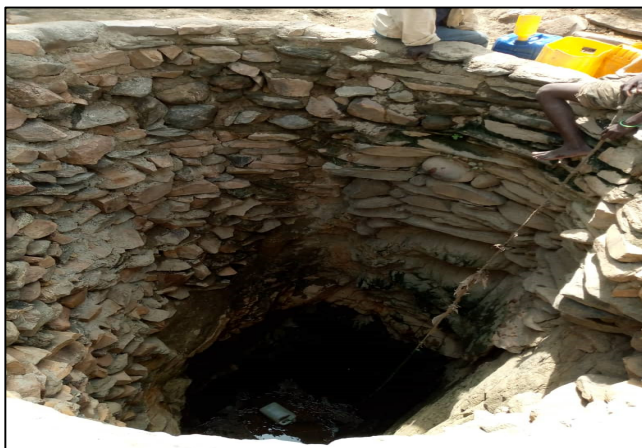
Photo 2 : Puits traditionnel d'environ 5 m de profondeur à Wafango (Mayo-Tsanaga)
